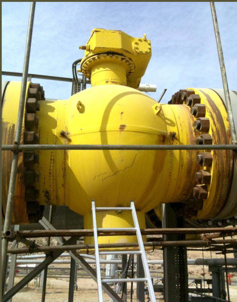
این نوع شیرها عموماً به دلیل آسیب دیدن Seat و یا ایجاد کانال و شیارهایی بر روی مجرایند دچار نشتی می‌شوند، برای رفع نشتی شیرهای توپی دستورالعمل زیر را اجرا کنید:
